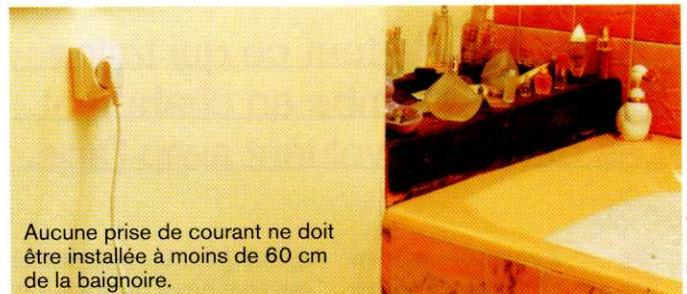
Aucune prise de courant ne doit être installée à moins de 60 cm de la baignoire.
